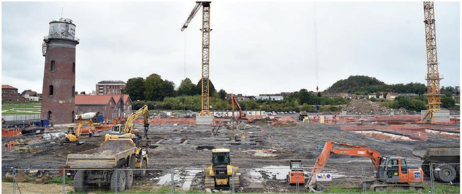
Le chantier du palais des congrès derrière la Serre numérique, est bien engagé. PHOTO BRUNO FAVA
